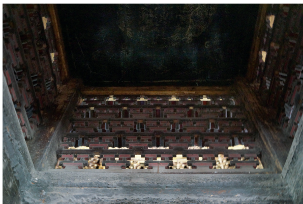
图26 旭光阁木坛城宫殿木构围墙
