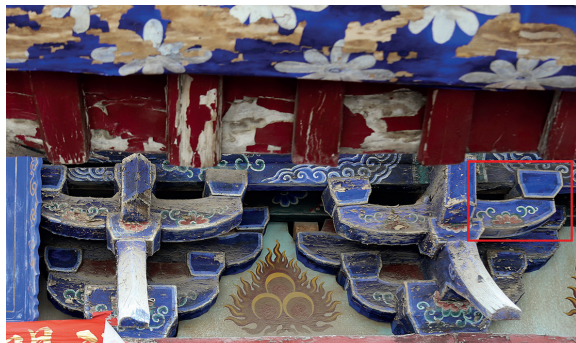
〔图二十〕大殿改动痕迹 1. 外檐斗栱改动痕迹 2. 梁架改动痕迹 3. 后檐内额与劓牵改动痕迹
