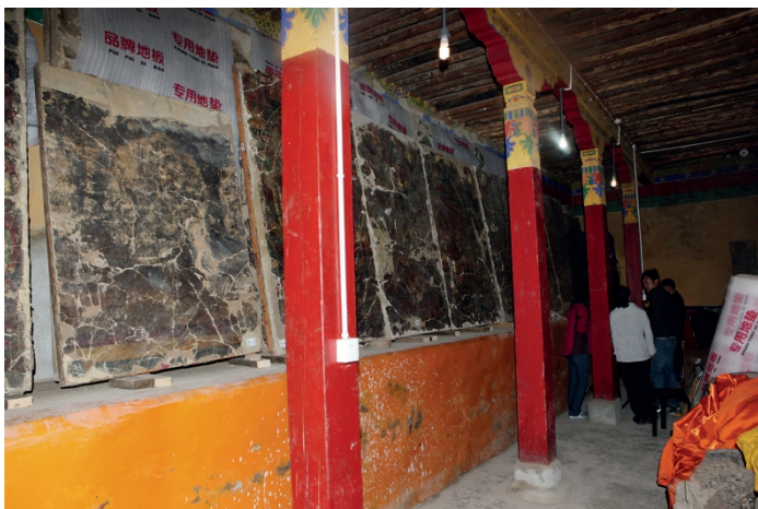
〔图一〕北围廊库房现状
