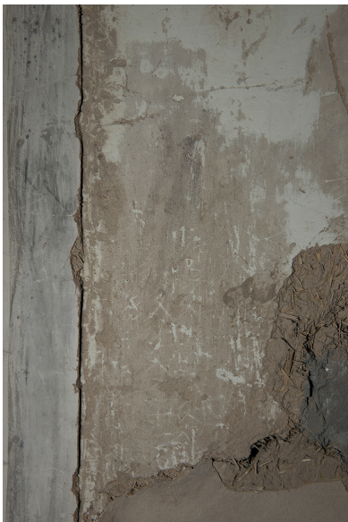
〔图六〕前室南壁西侧后期土坯墙拆除后留下双层壁画地仗层痕迹
