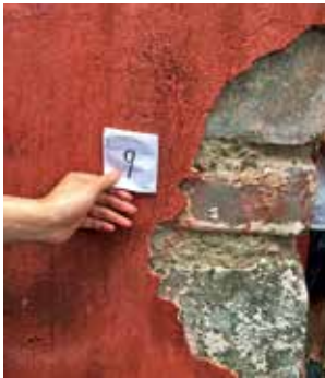
图 14 采样 9 麻刀灰全部脱落露出城砖
