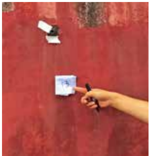
图 19 采样 13 墙面局部空鼓、褪色、变黑
