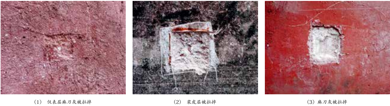
图9 拉拔实验现场情况
