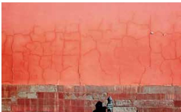
图2 墙面开裂
