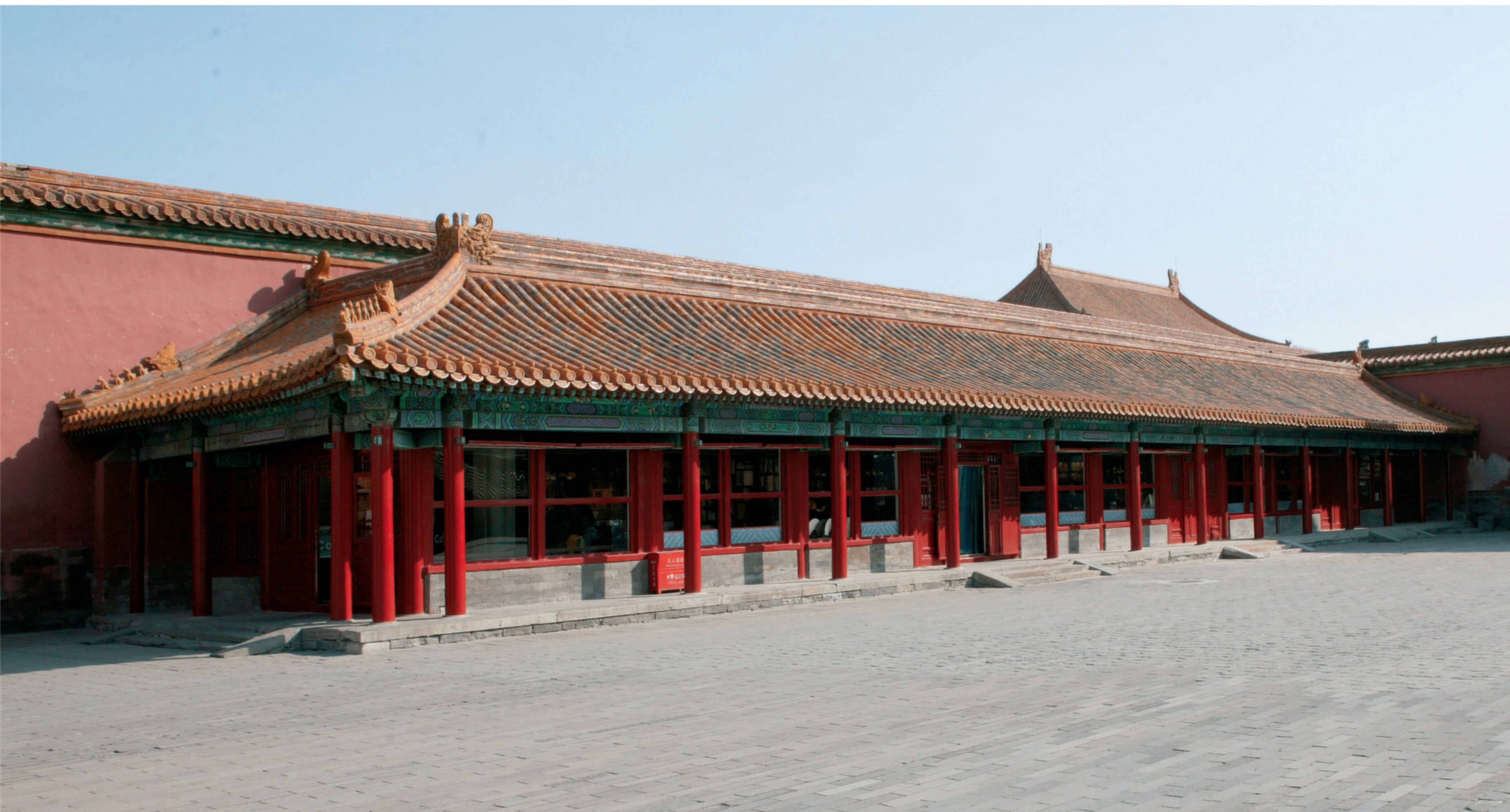
乾清门广场处原侍卫值房处现貌
