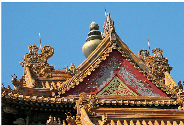
图 20 角楼上的明式正吻
