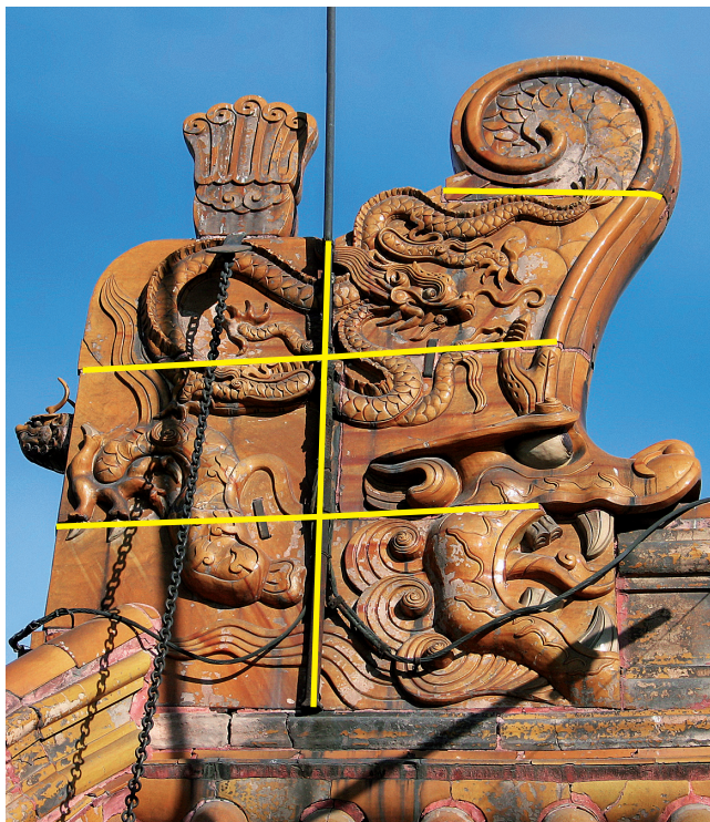
图8 神武门顶上的七拼正吻
