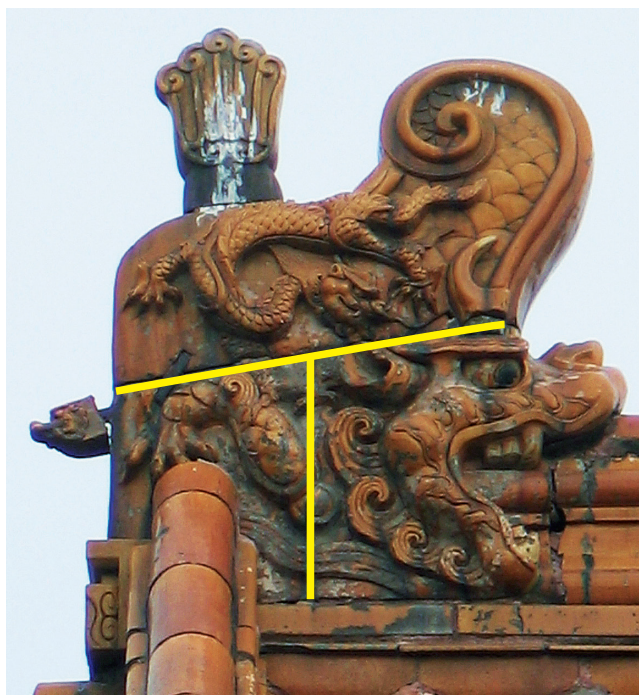
图5 传心殿倒座屋顶上的三拼正吻
