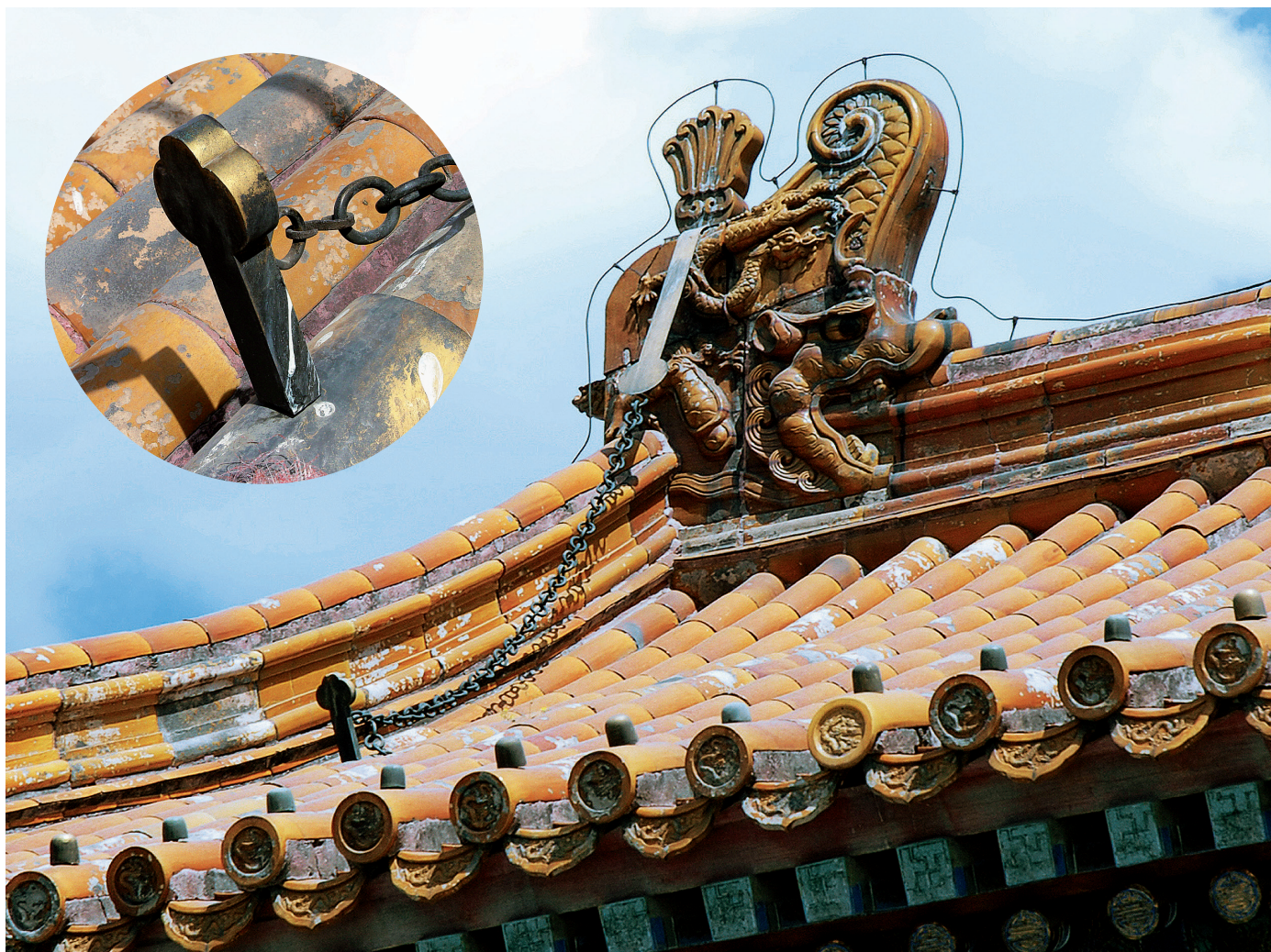
图 13-1 固定正吻的带、螭与栌的连接状态
