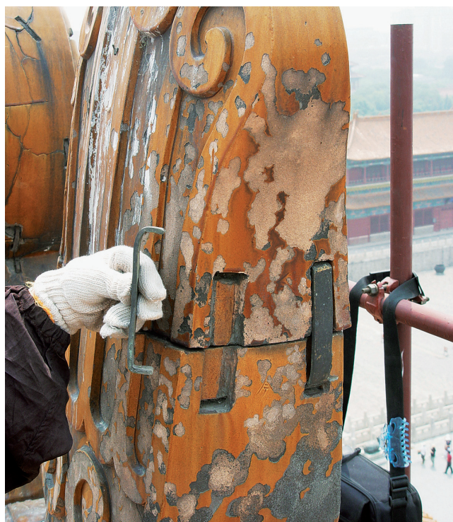
图 2 用于拼接琉璃部件的铜鎏金铜子
