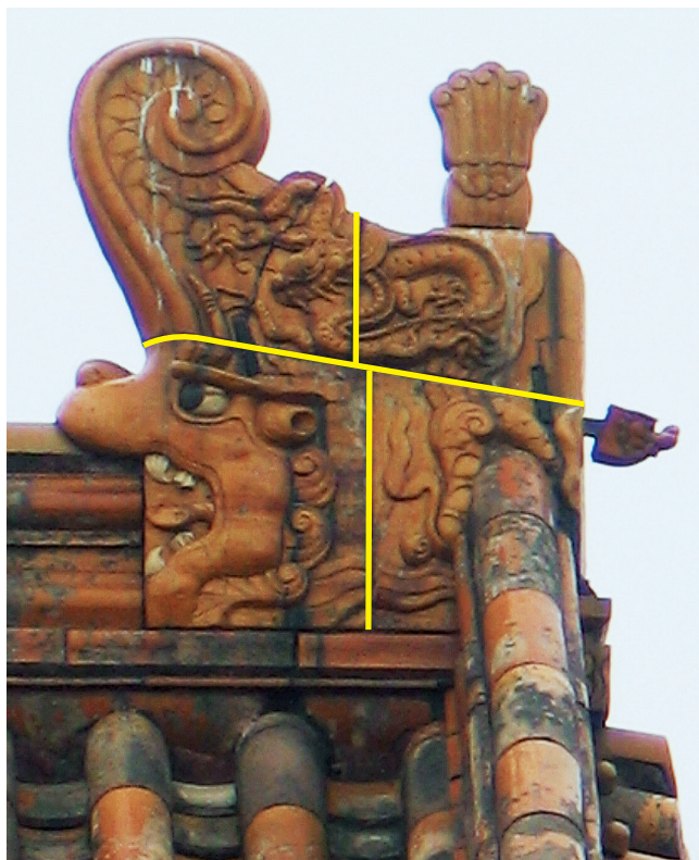
图6 传心殿屋顶上的四拼正吻
