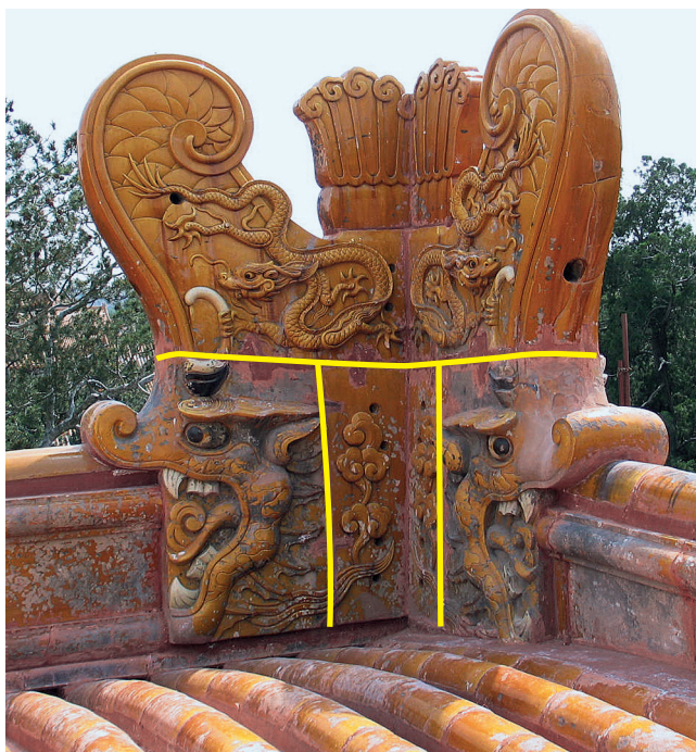
图 21 钦安殿屋顶上的三拼合角吻
