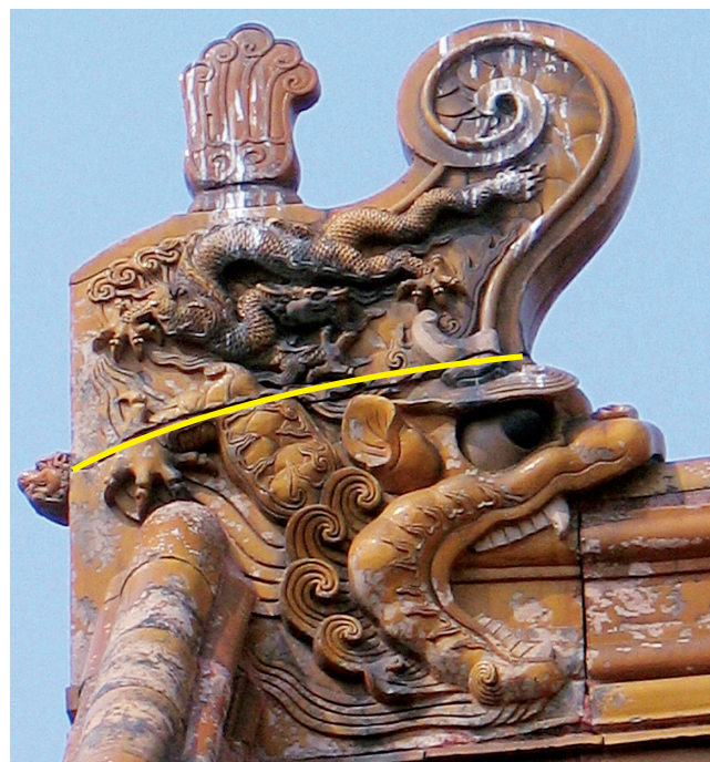
图 22 南薰殿屋顶上的两拼正吻
