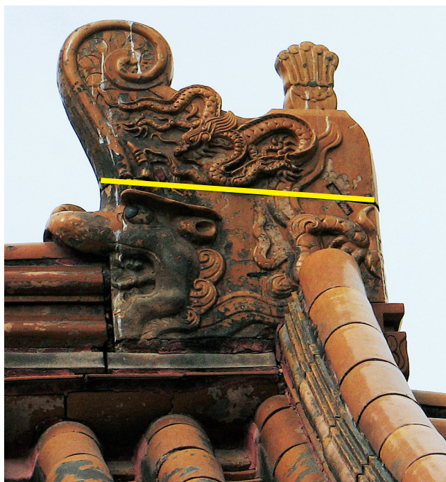
图4 咸安门顶上的两拼正吻
