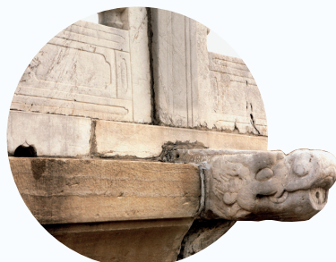
⑥ 栏板底部排水孔和螭首排水孔
