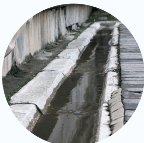
④ 保和殿北三层台底层石砌明沟
