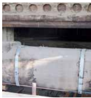
图 10 加固中的乾元阁大梁
