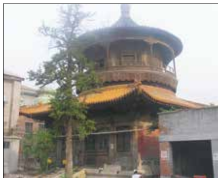
图 17 乾元阁修缮前全貌
