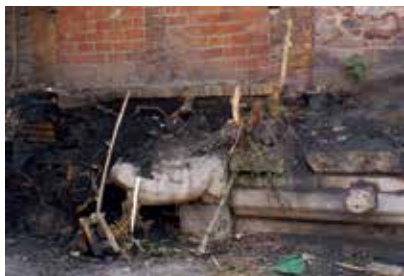
图5 乾元阁北临建房插入建筑墙体，堆煤渣，其中埋琉璃瓦
