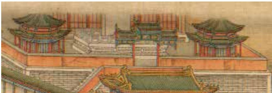
图3 转轮藏院门处1架一门两柱三楼垂花门式木牌坊
