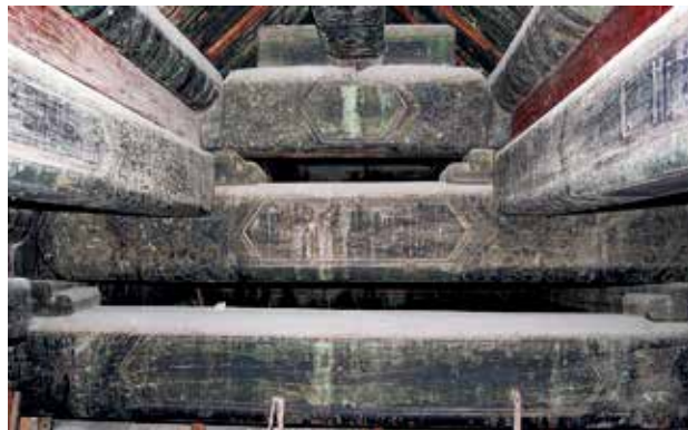
图 13 同道堂明间东缝梁架
