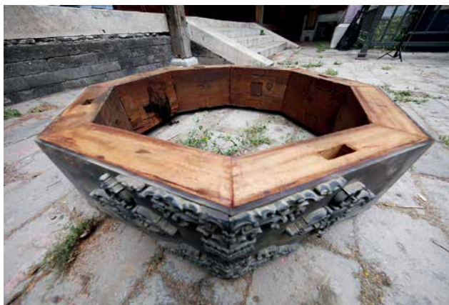
养心殿佛塔须弥座分解后的束腰部分，拼接处清晰可见直榫眼 须弥座的三个部分皆不用胶粘，仅有直榫相接
