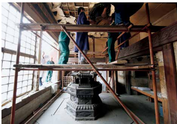
木塔搬运现场
