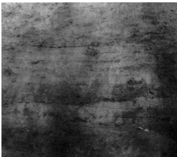
〔图六〕外城西城墙T1城墙夯层
