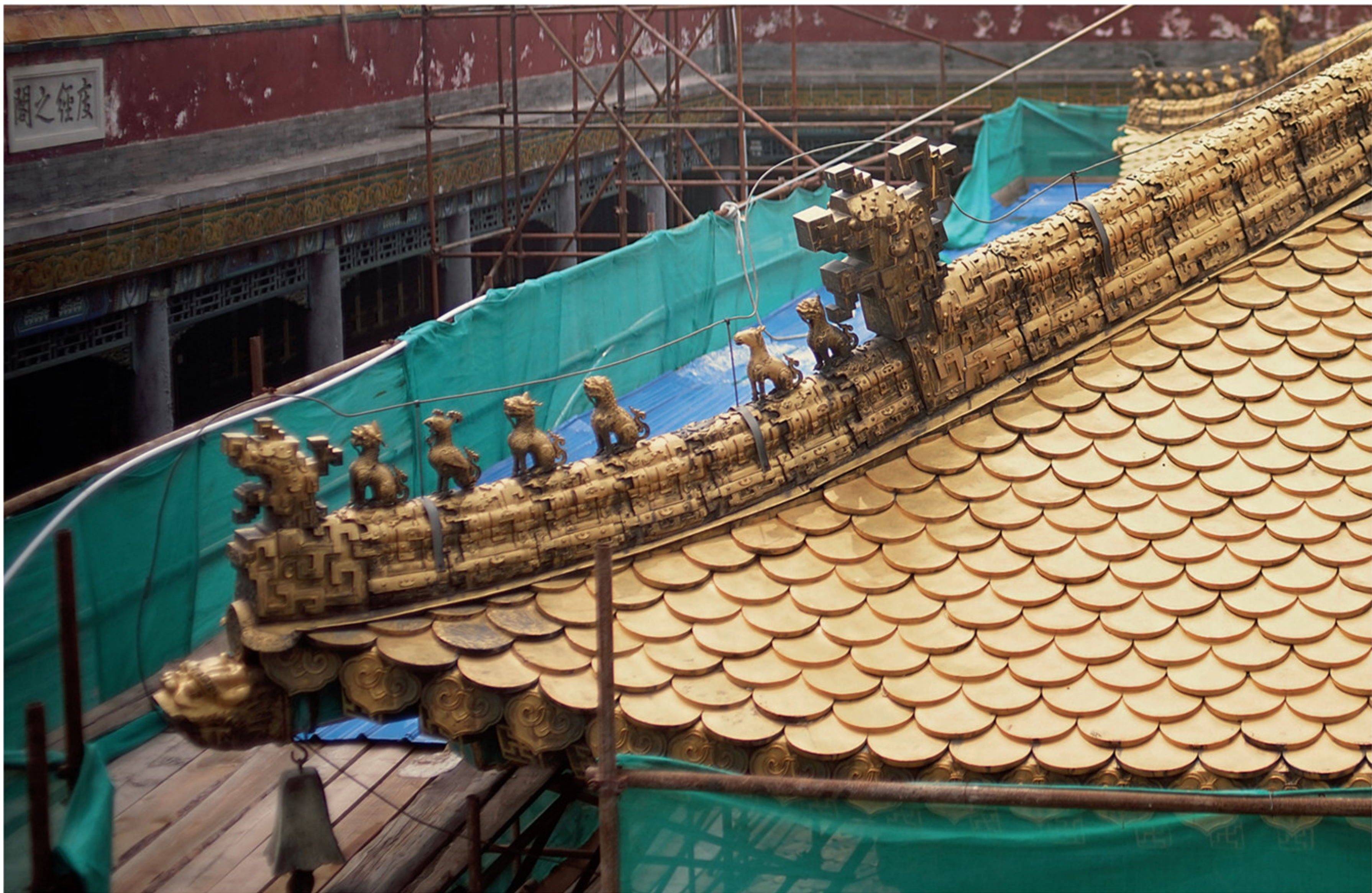
正在维修的普陀宗乘之庙万法归一殿金顶
