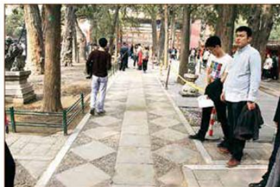
延晖阁南未铺设步道前
