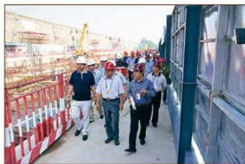
西玉河综合业务用房施工现场会议
