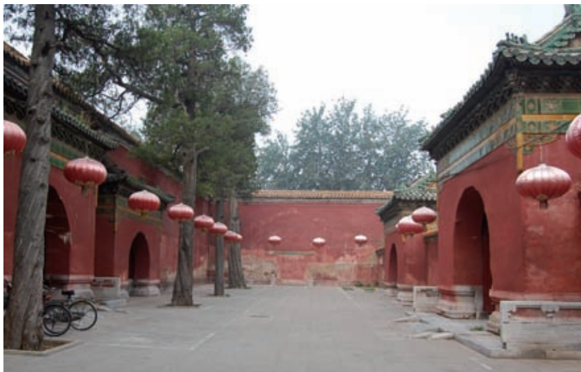
〔图八〕 两道山门和已封堵的西随墙门
