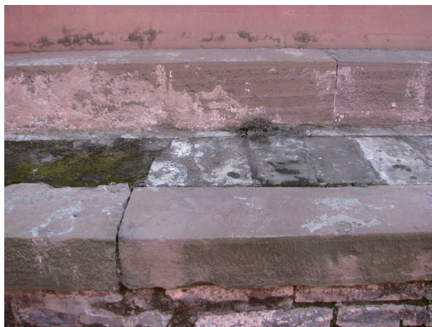
〔图十四〕洛伽胜境殿台基条石，下层为乾隆朝做法，上层疑后期做法。
