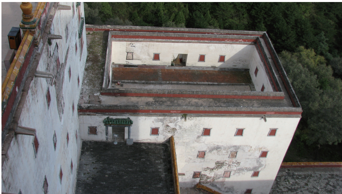
〔图二十一〕哑巴院所在楼体
