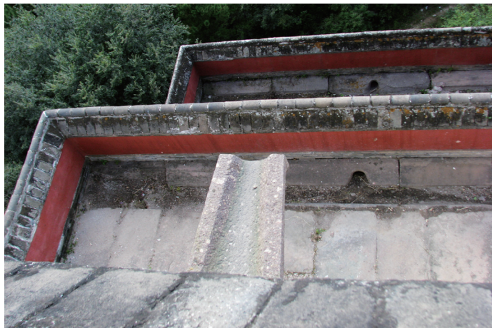
〔图二十二〕白台基座外西侧实心戗台（东向西俯视）
