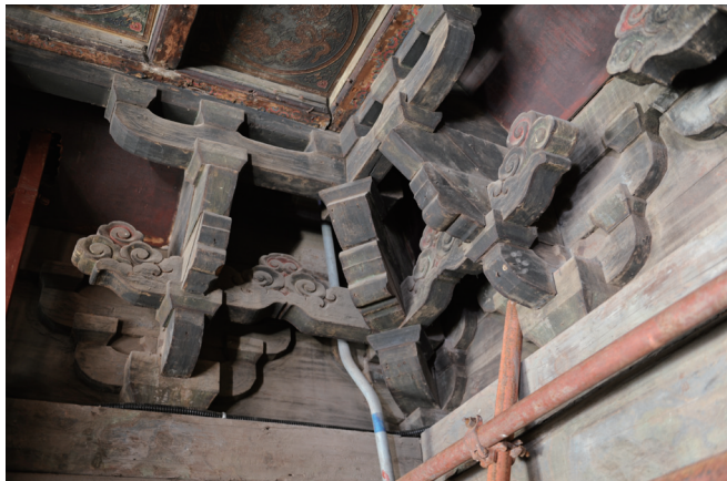
〔图七〕南熏殿斗拱里拽的隐刻上昂
