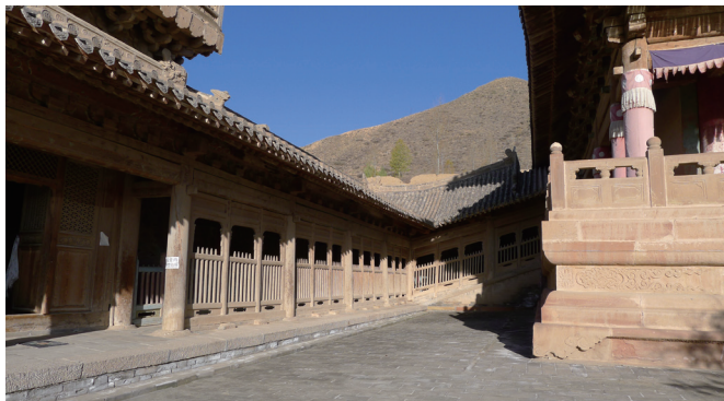
〔图二〕瞿昙寺隆国殿庑房与斜廊
